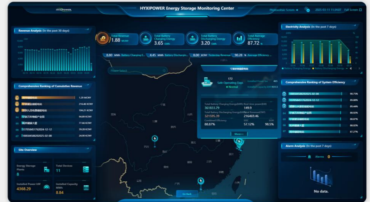
Centro De Monitorización De Almacenamiento Energético De HYXiPOWER
